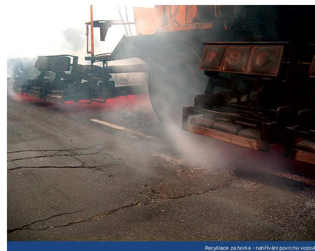
Recyklace za horka - nahřívání povrchu vozovky
