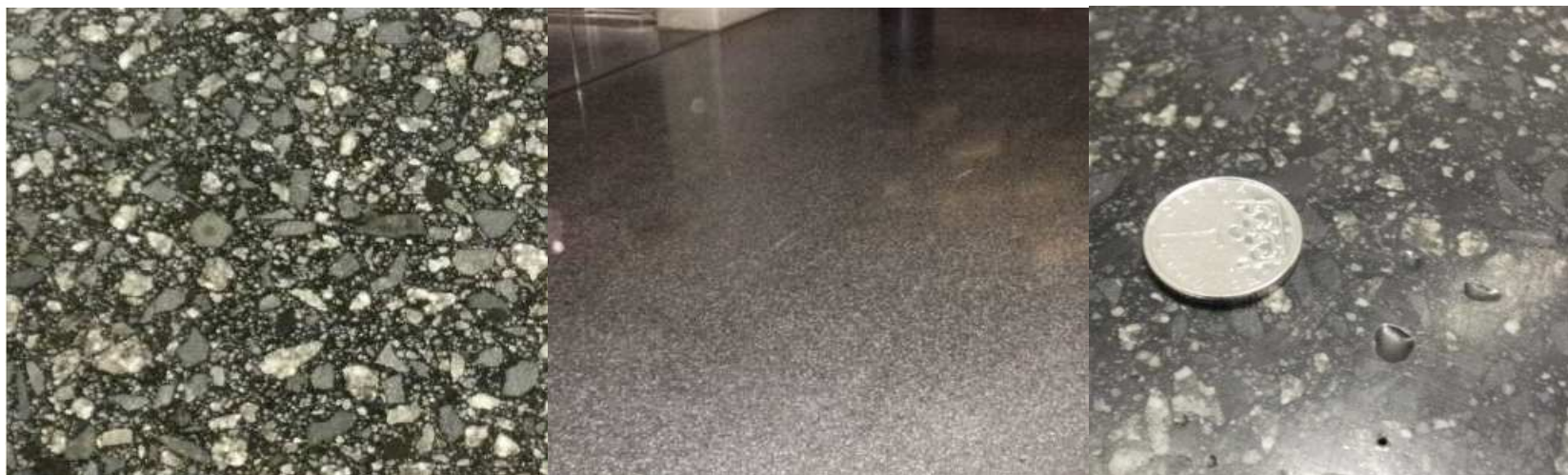
Bublinky na podlaze z litého asfaltu
