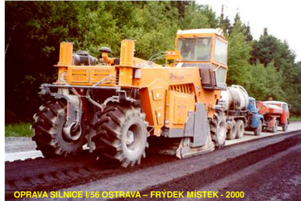
OPRAVA SILNICE 156 OSTRAVA – FRYDEK MÍSTEK - 2000
