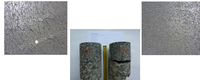
Textura položené vrstvy a kontrolní vývrty (EAC 11 + EAC 16)
