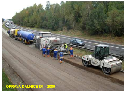
OPRAVA DÁLNIČE D1 - 2009
