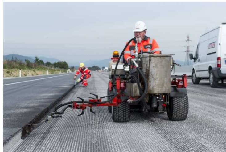
Nanášení pojiva na podélnou spáru
