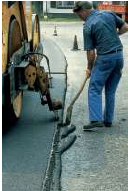
Nanášení pojiva na podélnou spáru
