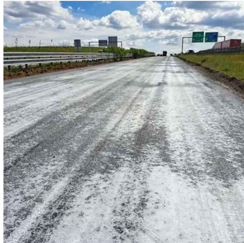
Aplikace mléka na geokompozit a spojovací postřík
