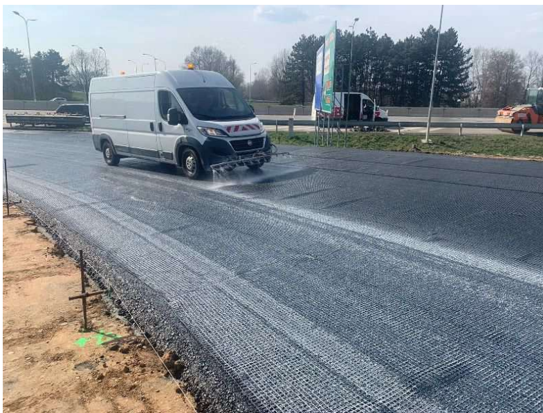
Aplikace mléka na geokompozit a spojovací postřik
