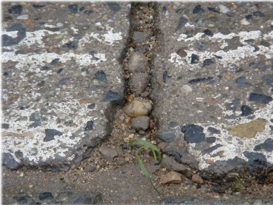
Betonová vozovka v průtahu Hustopečemi silnice II/425
