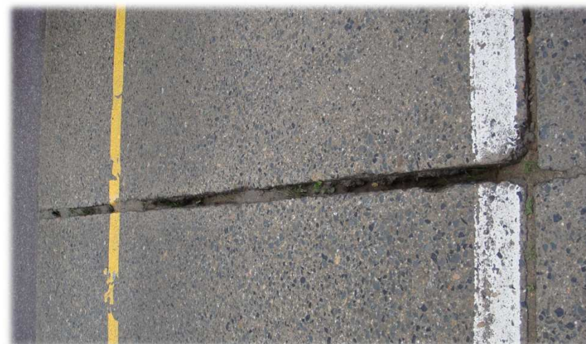
Betonová vozovka v průřezu Hustopečemi Stáří 40 roků
