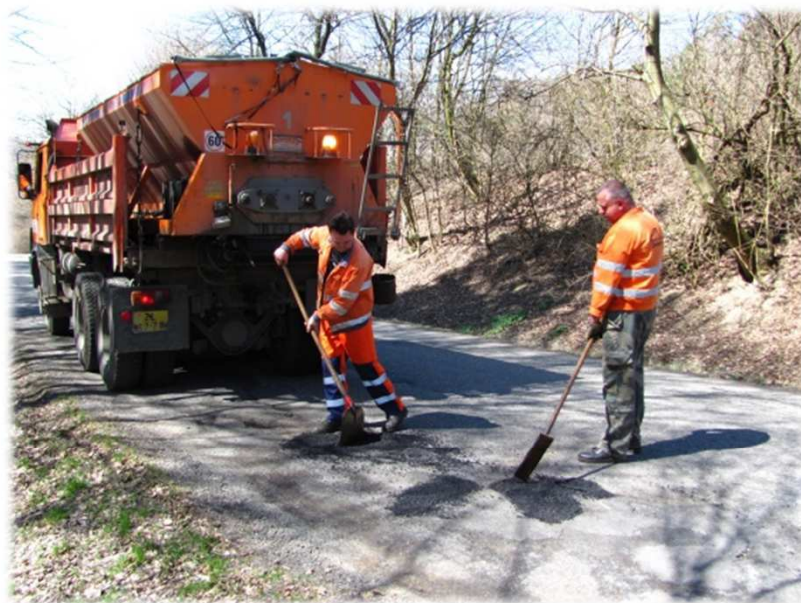
Oprava výtluků v obrusné vrstvě
