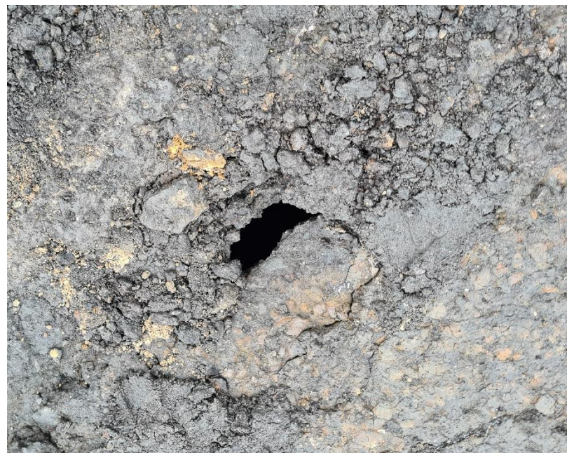
Porušená historická zděná stoka propojující rybniční soustavu – sil. I/22
