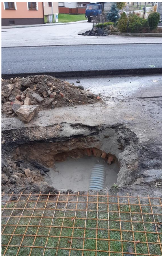
Sanace zřícené zděná cihlo / kamenná klenutá stoka propojující rybniční soustavu v obci– sil. I/22
