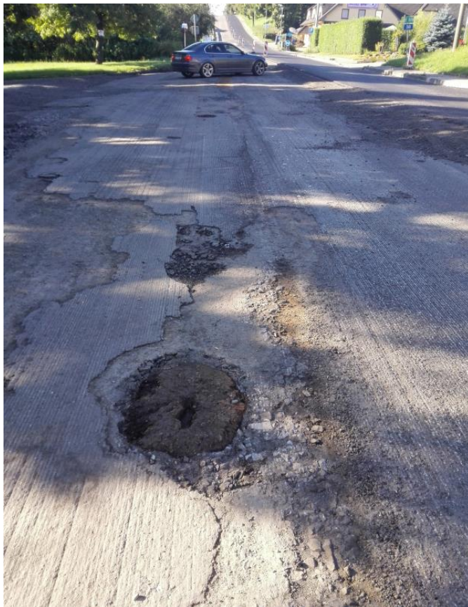
Výskyt stromů v konstrukci vozovky sil. I/38
