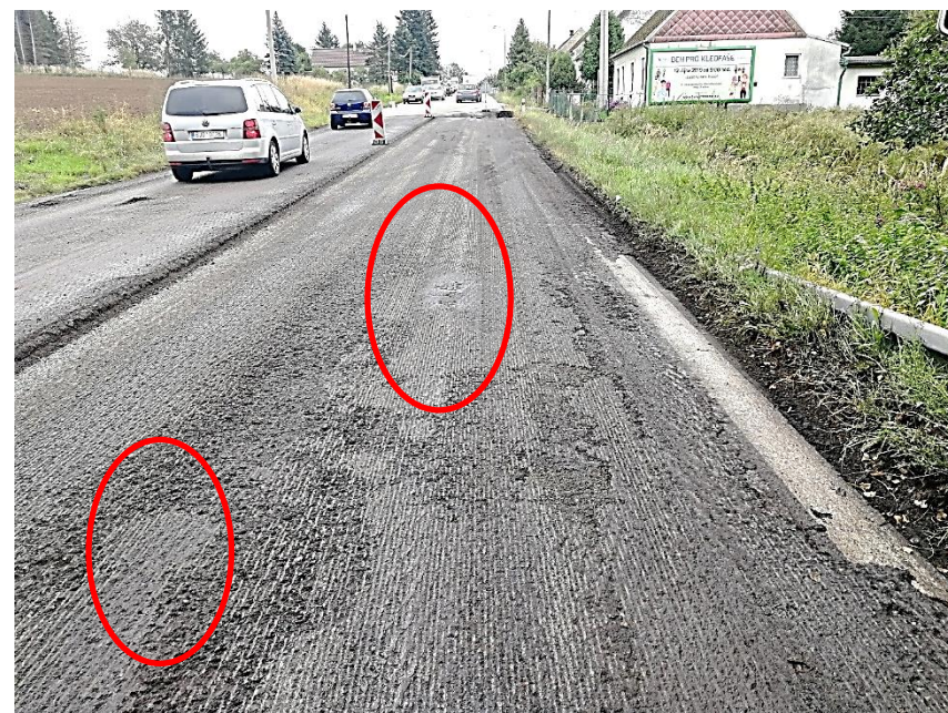
Historické opravy obrusné vrstvy na niveletě – 150 mm provedené ze směsí s dehtovým pojivem (sil. I/34)
