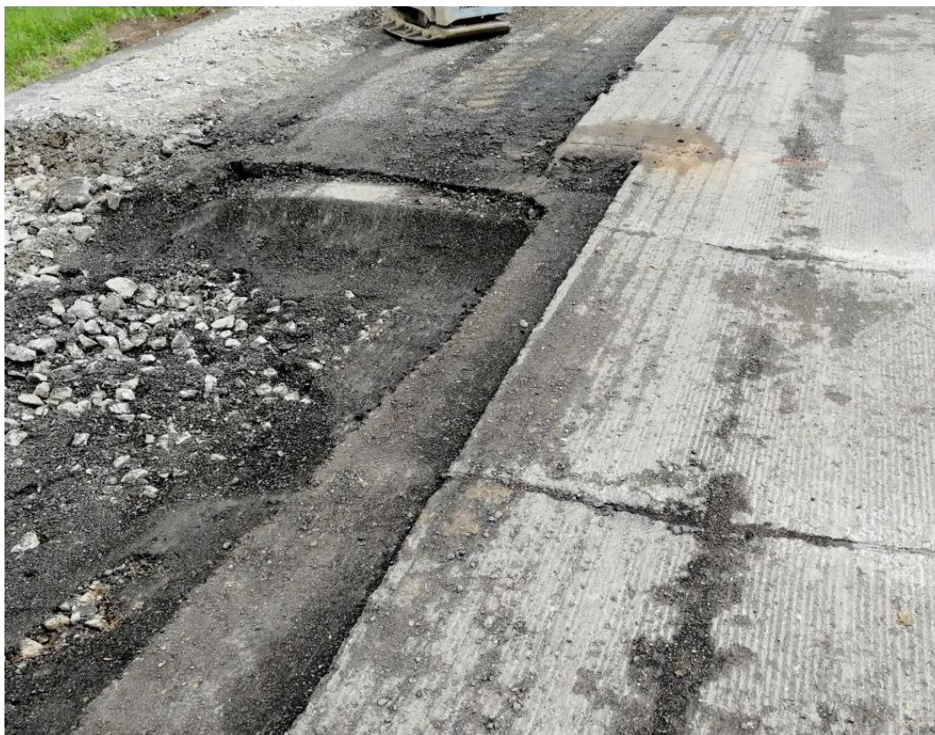
4 x rozšířená sil. I / 38, frézovaný povrch niveleta – 110 mm (Sil. I/38)
