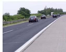
Sendvičový nátěr s PMB pojivem PMB na CB vozovce (D 11)
