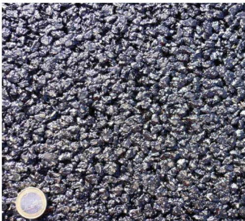
Asfaltová směs s PMB
