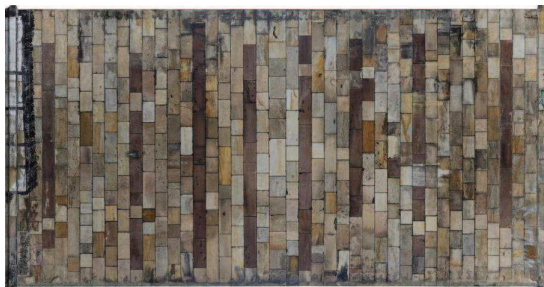
Negrelliho viadukt: fotoplán rozvinutého válce mostní klenby
