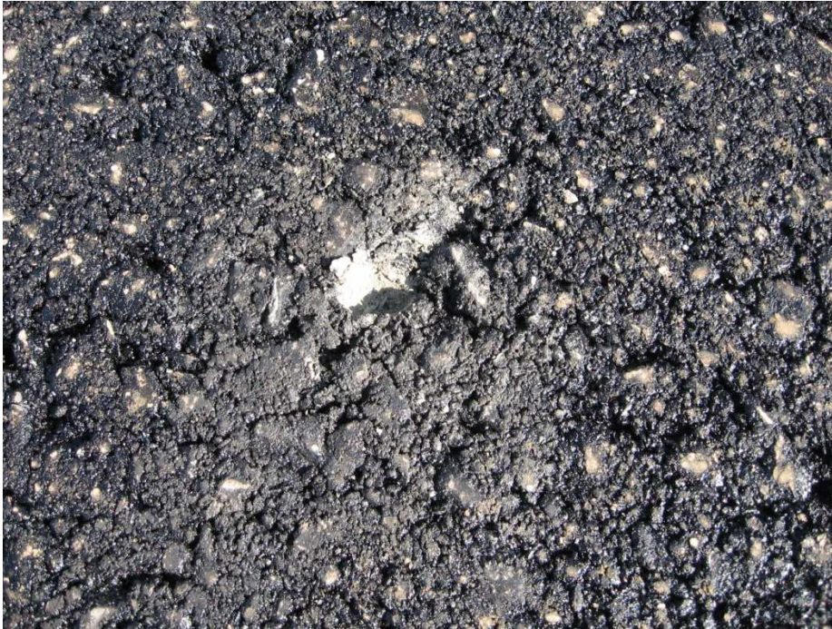
Rozpad měkkého zrna kameniva.
